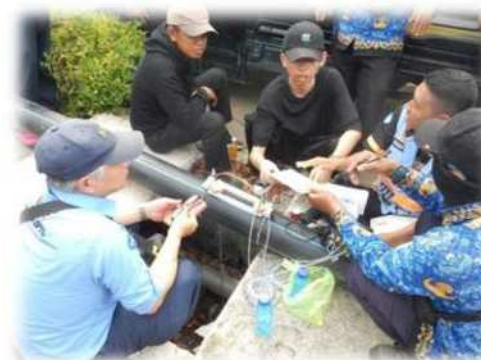
現地活動(ポータブル流量計設置)
