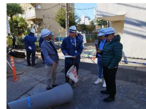
本邦研修(布設現場視察)
