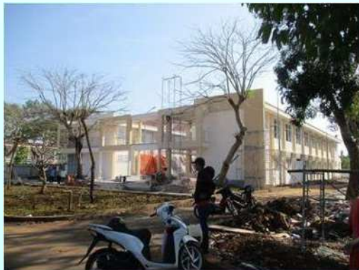
建設中の校舎
