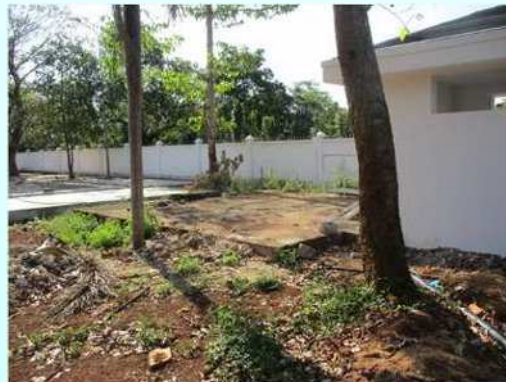
コンクリート製受水槽(地下式)
