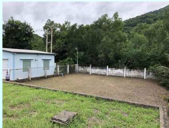
コンダオ浄水場
