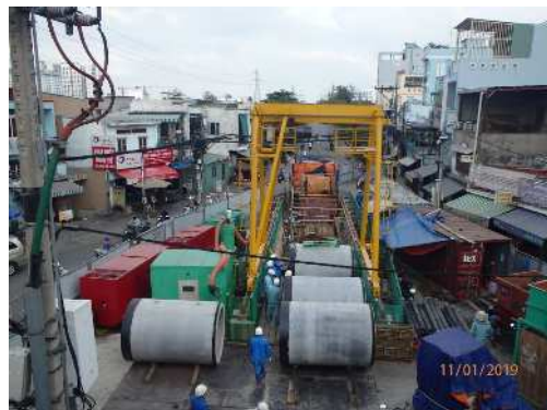
ホーチミン市施工状況 交通への影響を最小限に Minimizing impact to Ho Chi Minh city traffic
