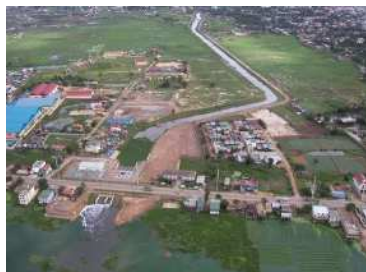
カンボジア国プノンペン市洪水防御・排水改善計画 The Project for Flood Protection and Drainage Improvement in Municipality of Phnom Penh (Cambodia)
