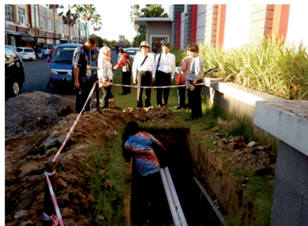
無収水対策の実施現場
