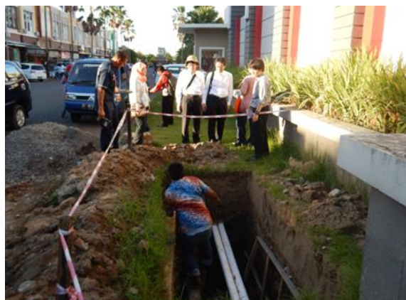
無収水対策の実施現場
