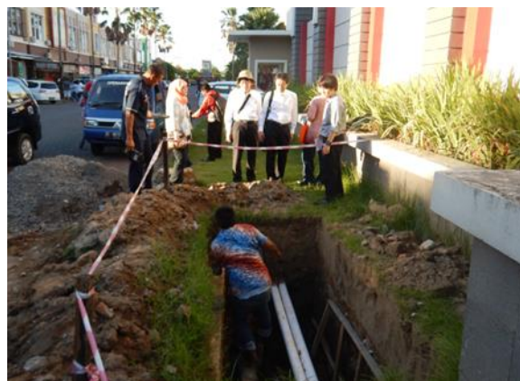
無収水対策の実施現場
