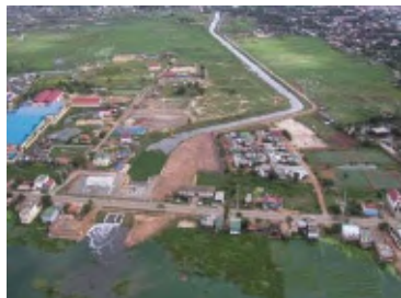
カンボジア国プノンペン市洪水防御・排水改善計画 The Project for Flood Protection and Drainage Improvement in Municipality of Phnom Penh (Cambodia)
