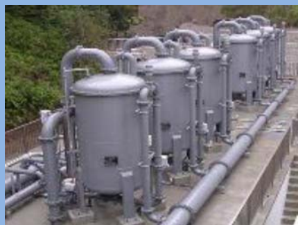
高濁度原水対応型浄水装置 ＝繊維ろ過（アクティファイバー） ＋砂ろ過システム
