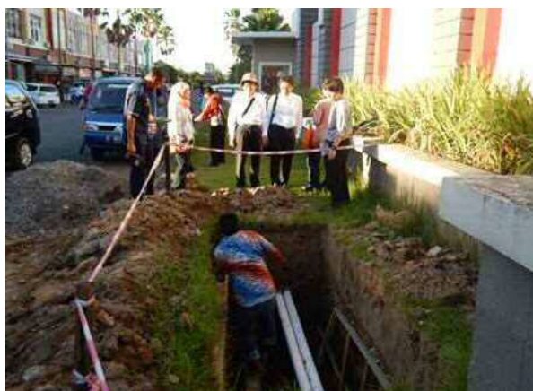
無収水対策の実施現場
