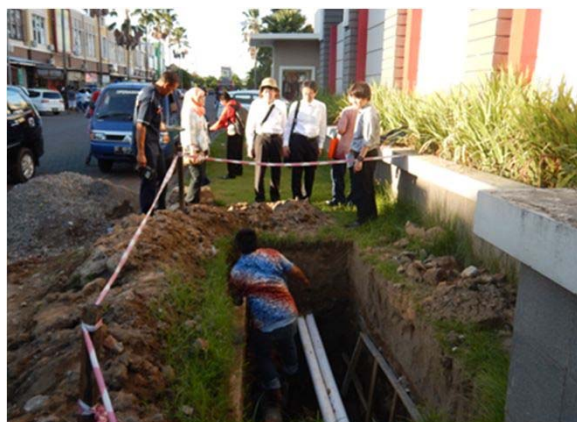
無収水対策の実施現場
