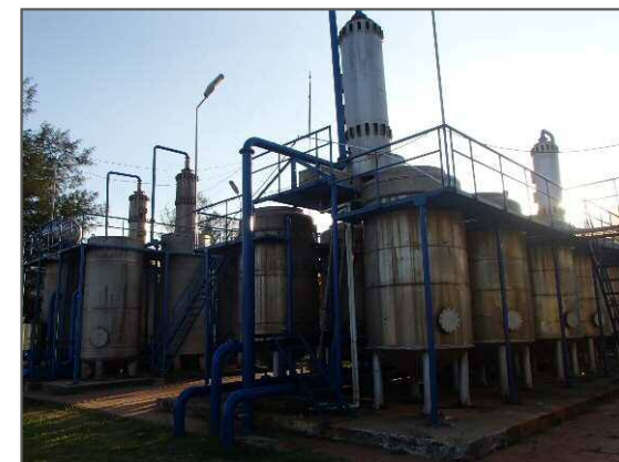
現地の浄水設備
