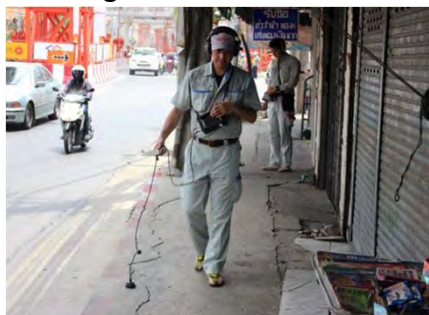
1.漏水探知機を用いた漏水調査
