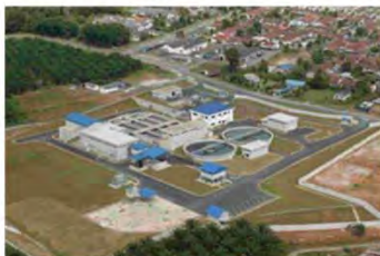
スンガラ下水処理場 日平均処理量: 15,000m 3 /日
