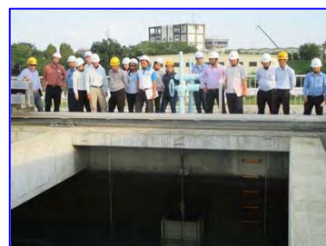
研修生による現場視察 （長沢浄水場）
