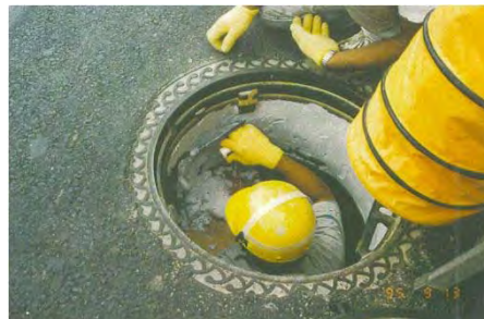
マンホール補修(セラミックコートD-3種工法)
