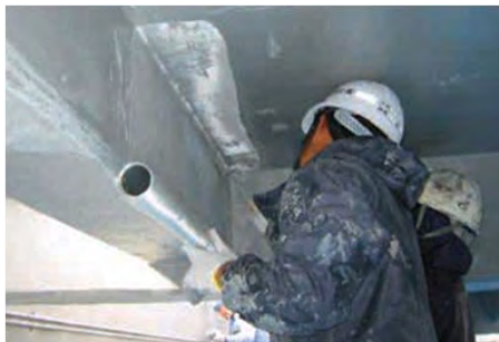
下水団規格合格(ガラスクロス積層工法)
