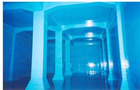
上水施設への施工例(SC-2N工法)
