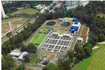
ダマンサラ下水処理場 日平均処理量: 25,000m 3 /日
