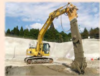
中層混合処理工法の施工状況
