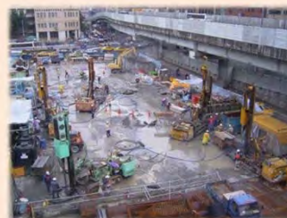
薬液注入工法の施工状況(海外事例)
