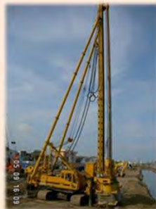
深層混合処理工法の施工(海外事例)
