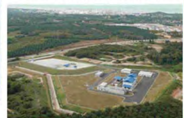
スンガイ・ウダン汚泥処理場 日平均処理量: 250m 3 /日
