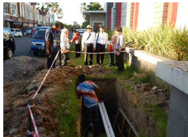
無収水対策の実施現場
