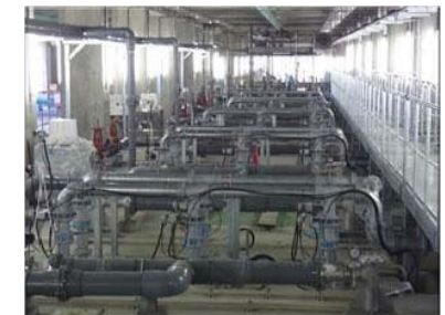
実証施設(高知市下知下水処理場)
