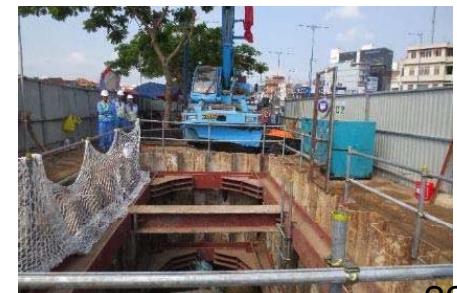
立坑施工の様子(H29.3) (ホーチミン市)
