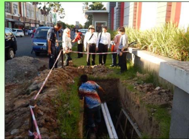
無収水対策の実施現場
