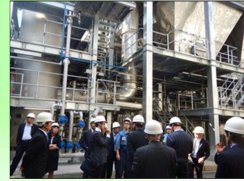
入江崎総合スラッジセンター視察の様子
