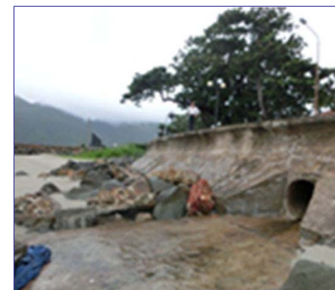
雨水・生活排水放流口の様子
