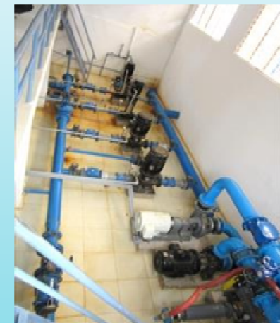
【写真5: 既設配水ポンプ室】
