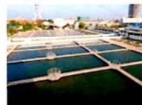
プノンペン市 プンブレック浄水場
