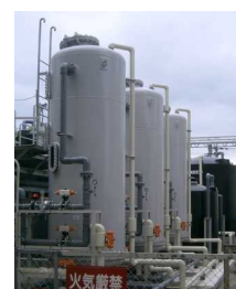
55m³/hホウ素除去装置
