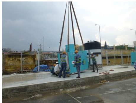
装置を開梱し設置
