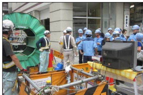
更生工法の施工状況視察 (2011年7月 於:東京都)
