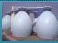
消化ガス発電
