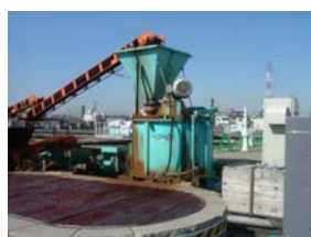
ろ過池更生工事
